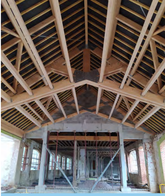
La structure du bâtiment des anciens ateliers
