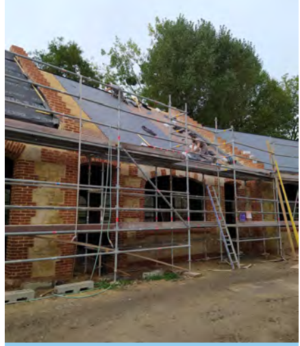
Finalisation de la toiture, nettoyage et rejointoyage des pierres (août 2020)
